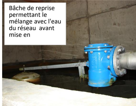
Bâche de reprise permettant le mélange avec l'eau du réseau avant mise en
