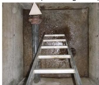
Regard en béton en bon état, condensation importante, grillage de protection efficace pas d'insectes dans le regard
