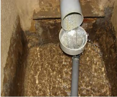
Echelle corrodée, forte granulométrie du béton
